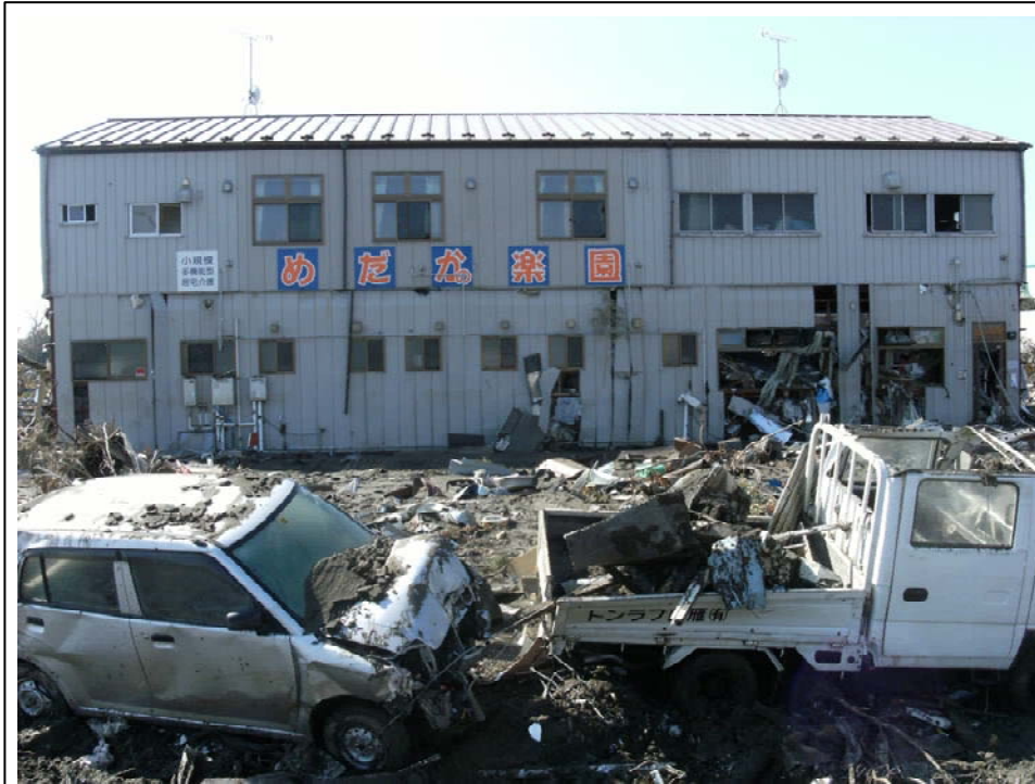
津波の被害を受け全壊となった「めだかの楽園」
